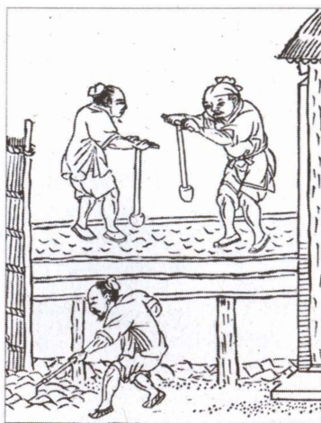
Трамбовочные работы при строительстве китайских стен. Guo Po, Er ya yin tu (1801).
